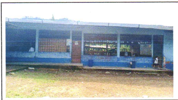
FOTO 15: Fabricación e instalación de puertas de metal en módulos
